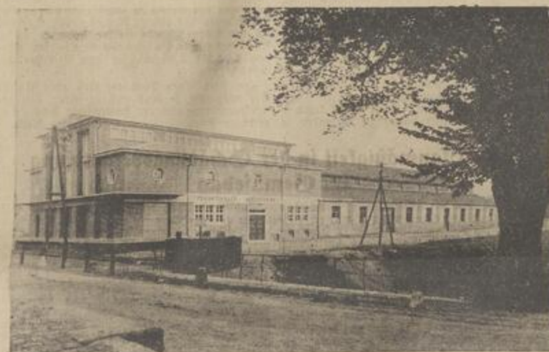
Markthalle in Heidesheim
