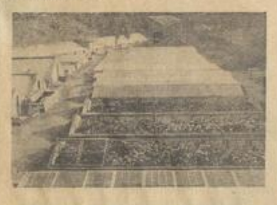
Teilansicht des Betriebes J. T. Hofmann, Freiburg-Breisgau
