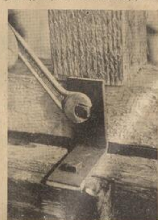
Unter dem Pfosten, zwischen Bodenschwelle und Sockel, liegt das Flächeneisenstück. Der Winkel erhöht die Festigkeit des Bauwerks. Abb. Steffek.
