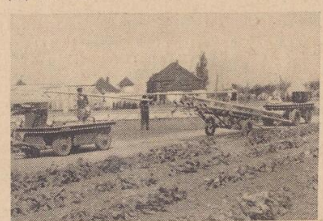
Abb. 2: Elektrokarren, eingesetzt für das schnelle Umsetzen von Beregnungsanlagen.
