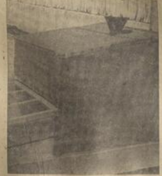
Abb. 1 (links): Außenansicht einer kleinen Kesselanlage für Mistbeetquartiere. Abb. 2 (rechts): Blick in den Kesselraum (Kesselloch), in dem außer dem Kessel auch noch Koks untergebracht werden kann.
