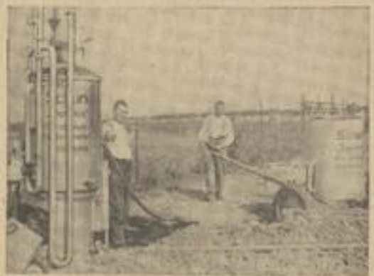
Die Komposterde wird auf dem Erdlagerplatz mit Hilfe eines jahrbaren Dampfkastens entseucht.
