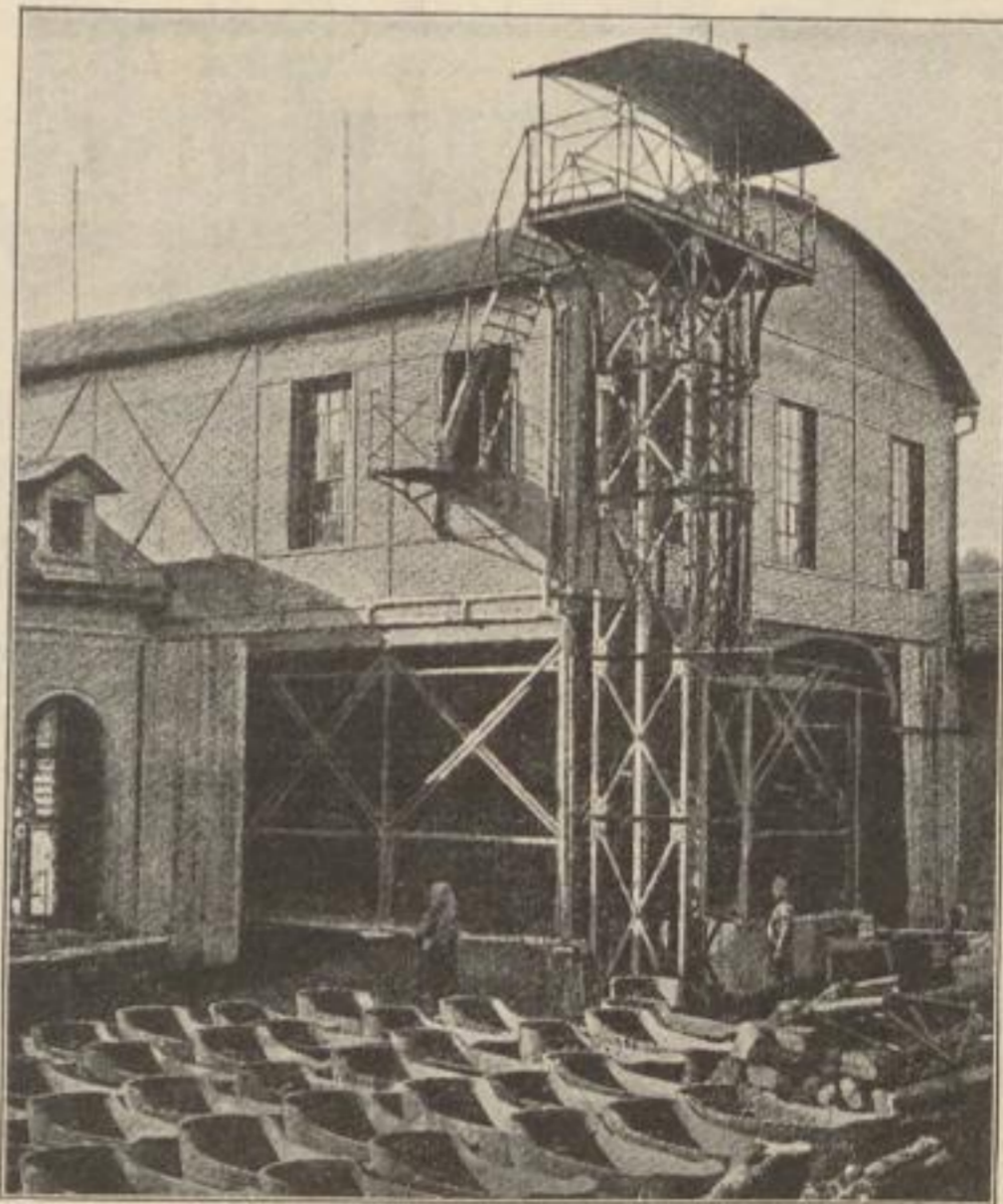
Moorbereitungs-Anlage zu Bad Elfter 200) .
