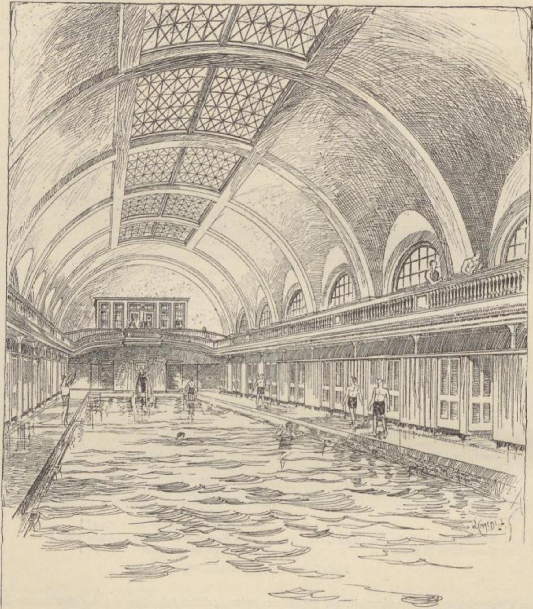
Schwimmhalle im öffentlichen Bad zu Brookline 214 .
