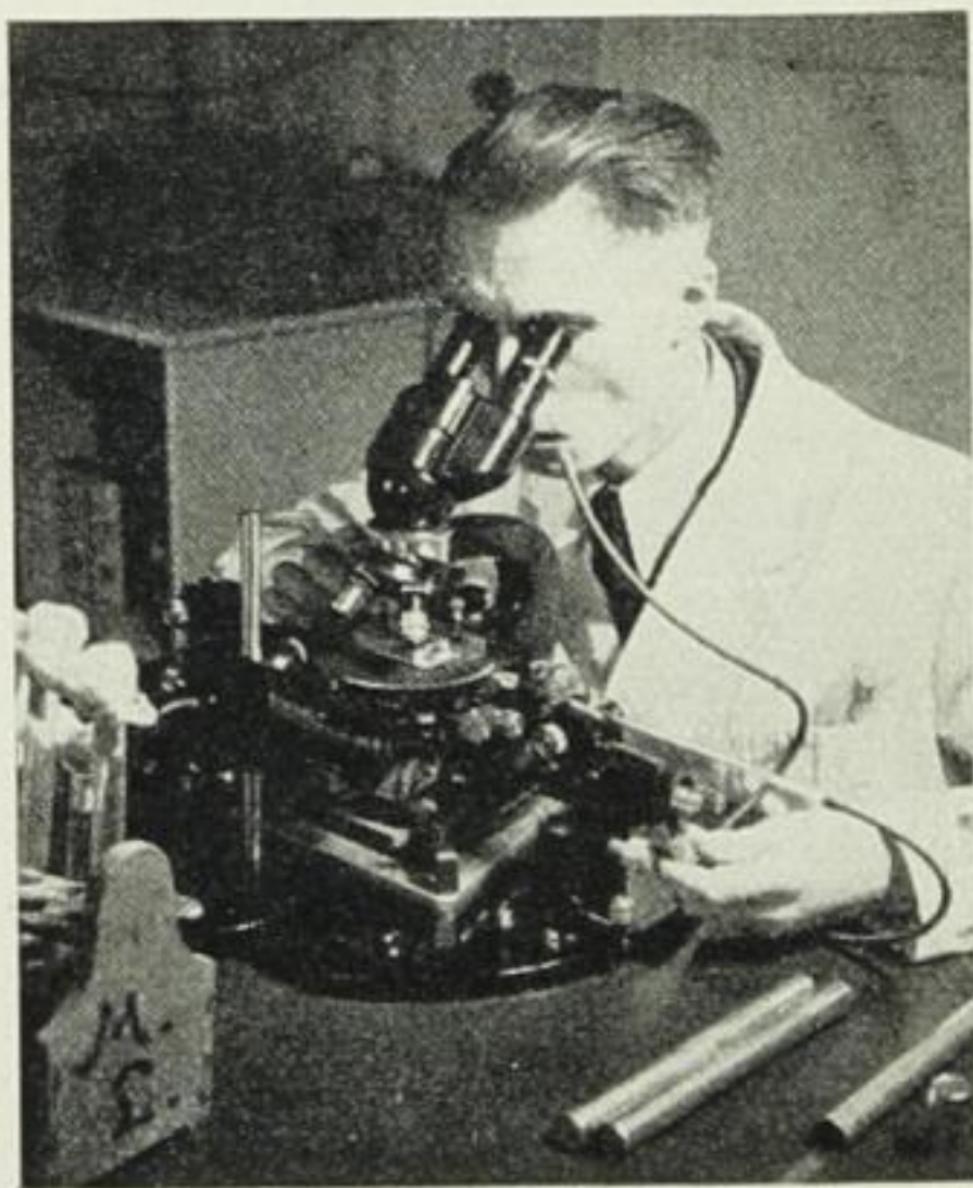
Welch ein technischer Fortschritt in 50 Jahren!: Dieser sinnreich konstruierte Apparat, „Mikromanipulator“ genannt, ist eine Bazillenfalle. Durch den dünnen Schlauch, der in einem Glasröhrchen mit haarfeiner Spitze endet, wird unterm Mikroskop ein einziger Bazillus angesaugt. Er wird der Stammvater einer Bazillen-Reinkultur
