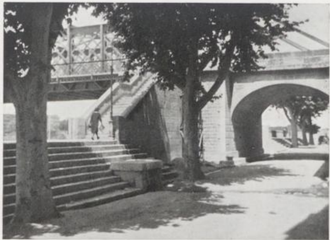
Abb. 21 Die Rhonebrücke bei Arles/Photographie 1931
