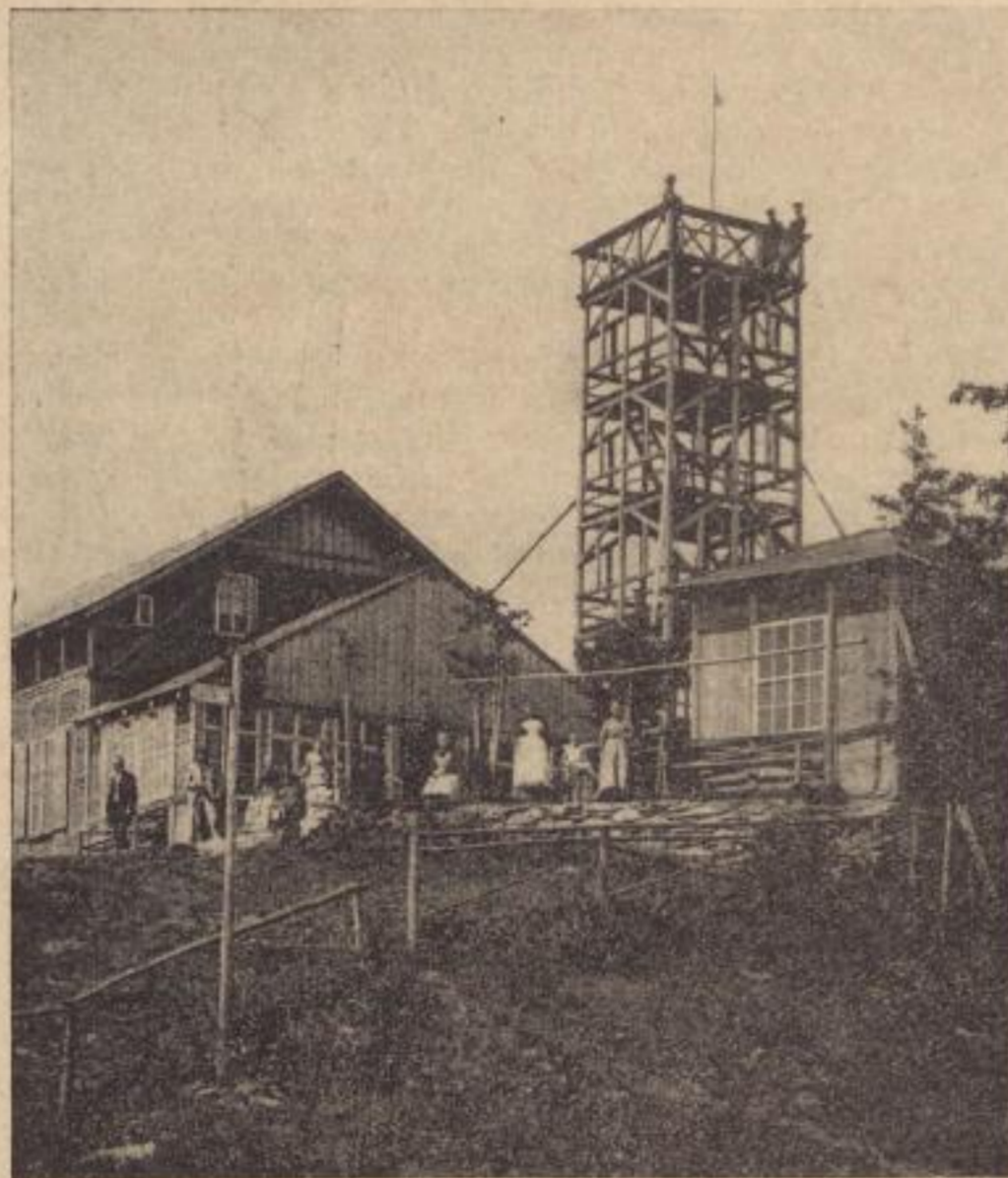
Der alte hier abgebildete Holzturm wurde 1898 durch einen Blitzschlag so stark beschädigt, daß er abgetragen werden mußte.
