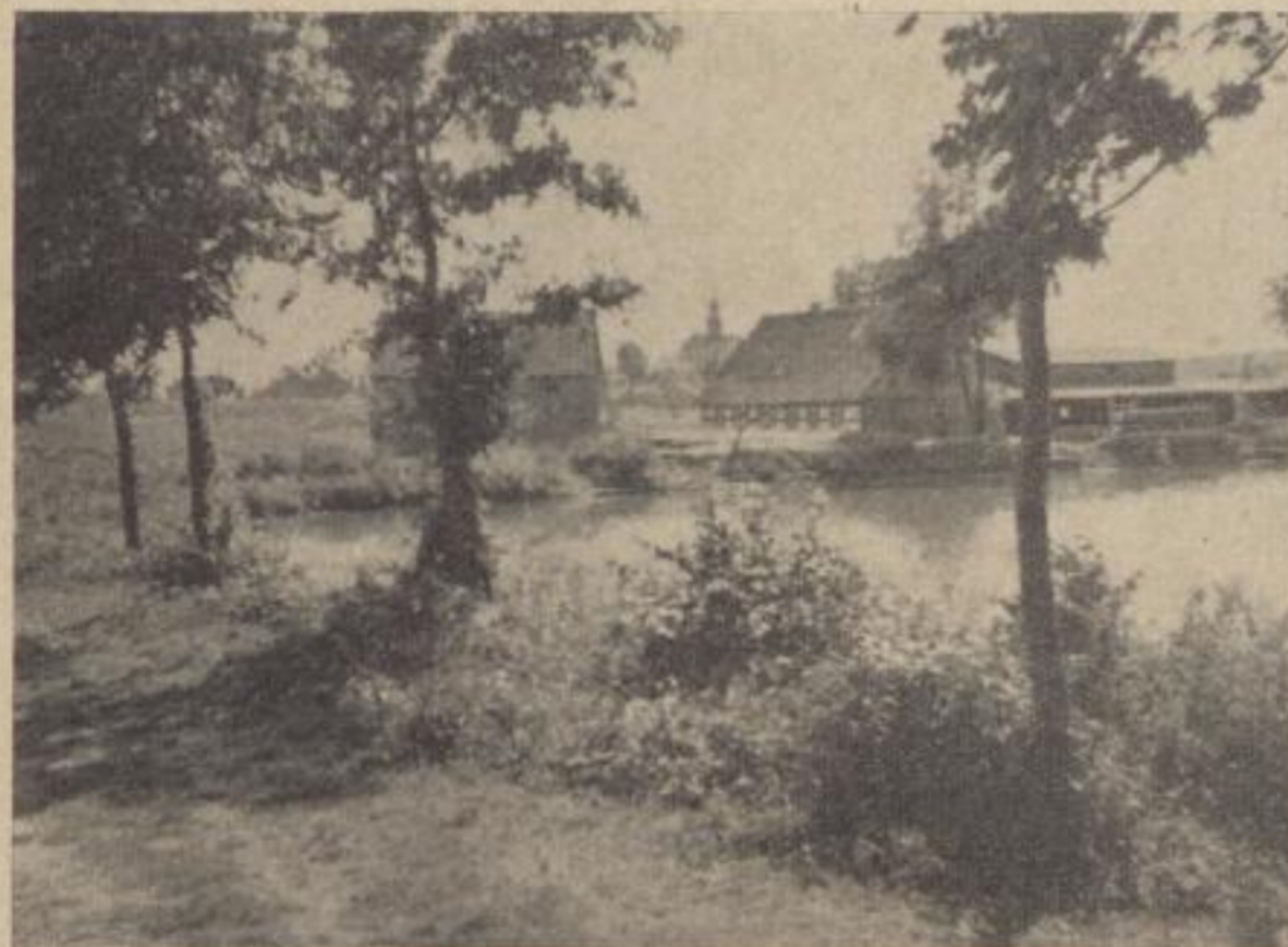
Die schöne alte Brettmühle am Oberen Teich
