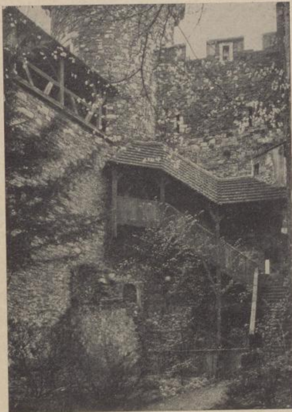
Treppe und Wehrgang in der Gröditzburg
