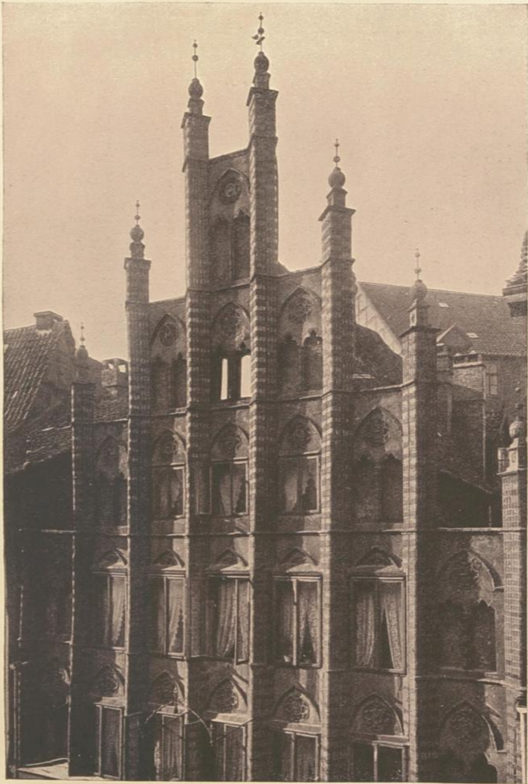
Abb. 3. Haus Knochenhauerstraße 28 (c. 1460)
