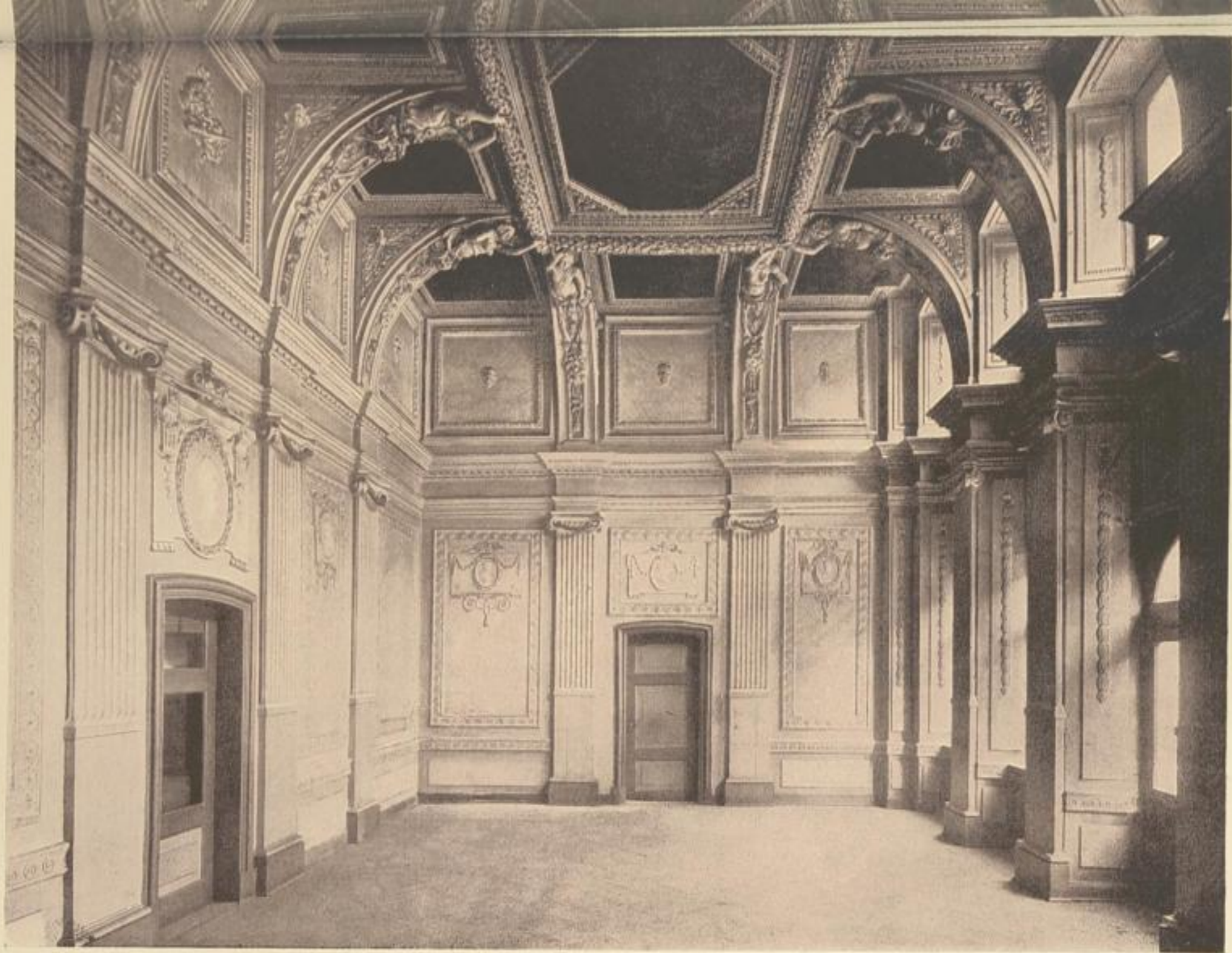
Abb. 24. Festsaal des Redenhofes, abgebrochen, jetzt Restner-Museum (Decke c. 1670, Wände c. 1790)
