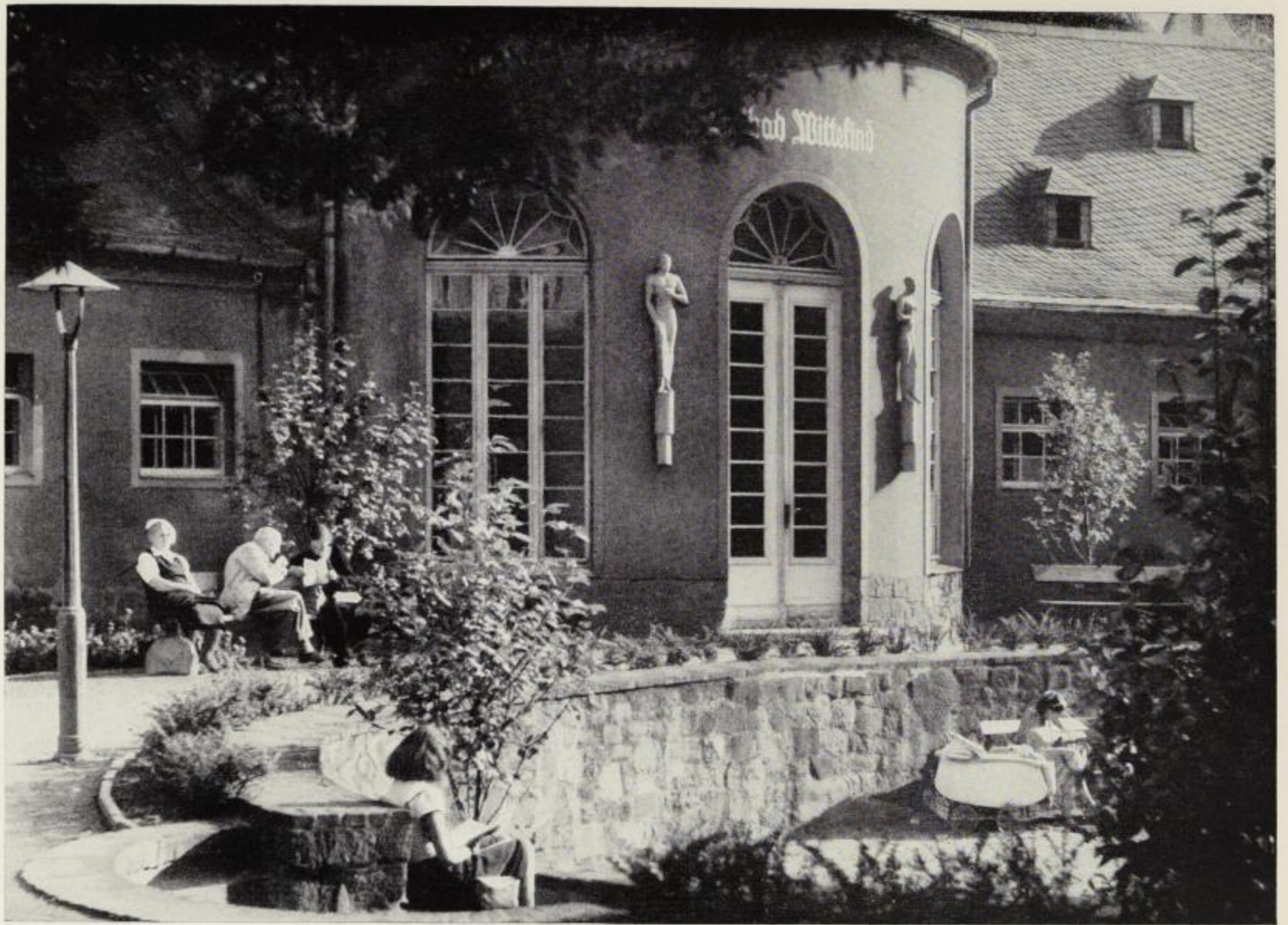
Bade- und Kurmittelhaus des Solbades Wittekind in Halle-Giebichenstein
