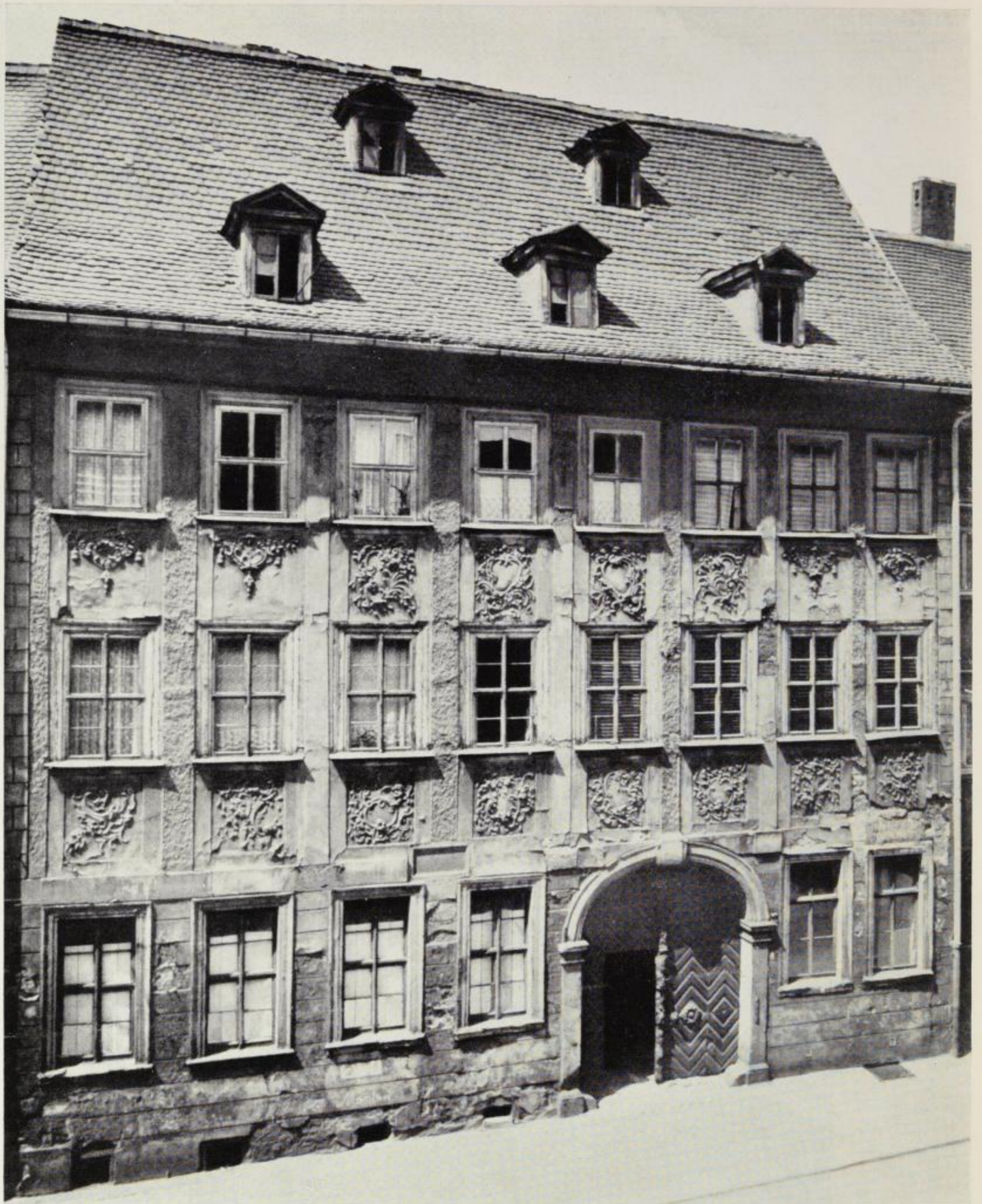
Rokokofassade des Hauses Rannische Straße 17
