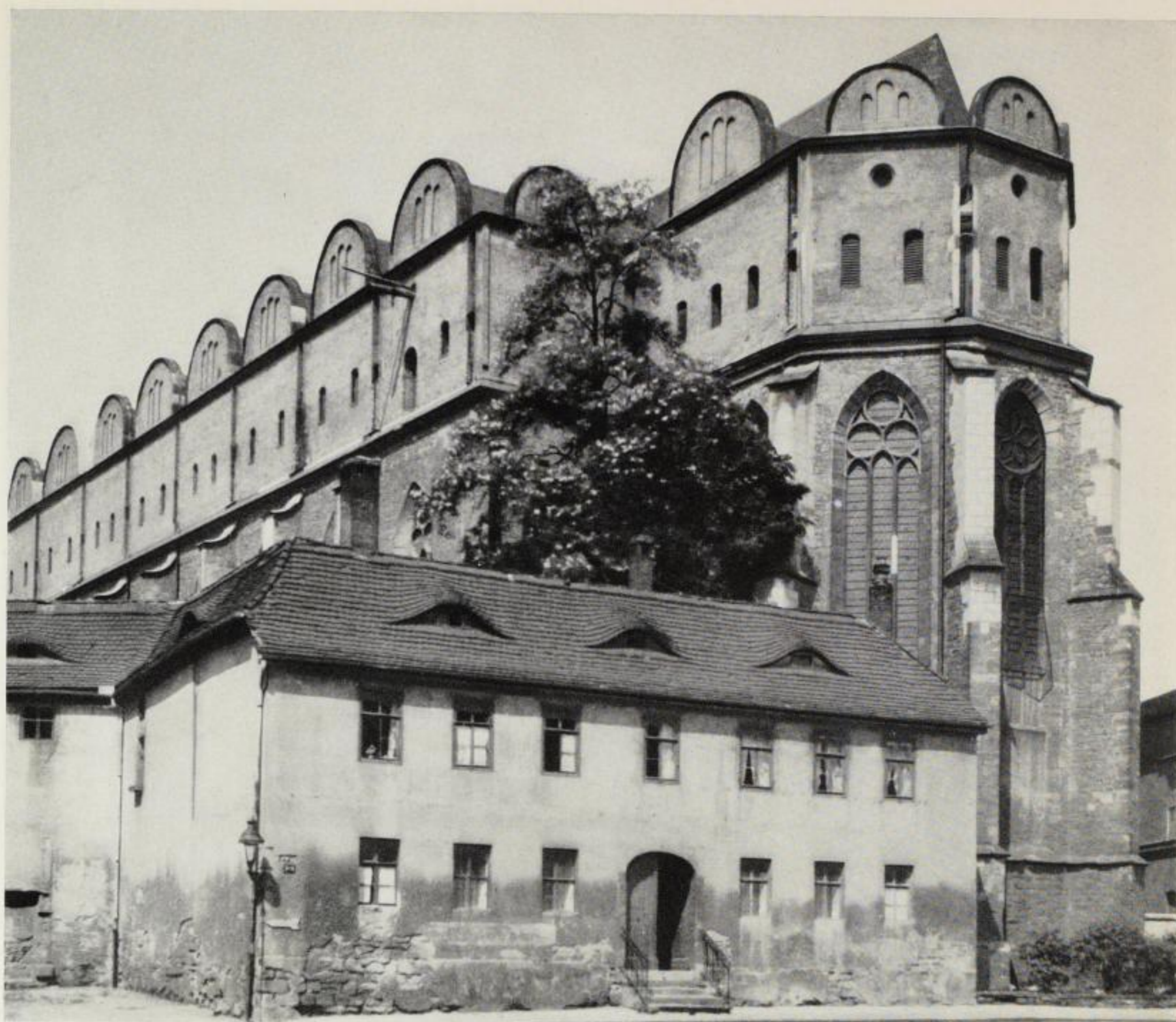
Dom- und Schloßkirche, um 1290 als Dominikanerkirche erbaut. Der Giebelkranz wurde 1525 bis 1535 aufgesetzt
