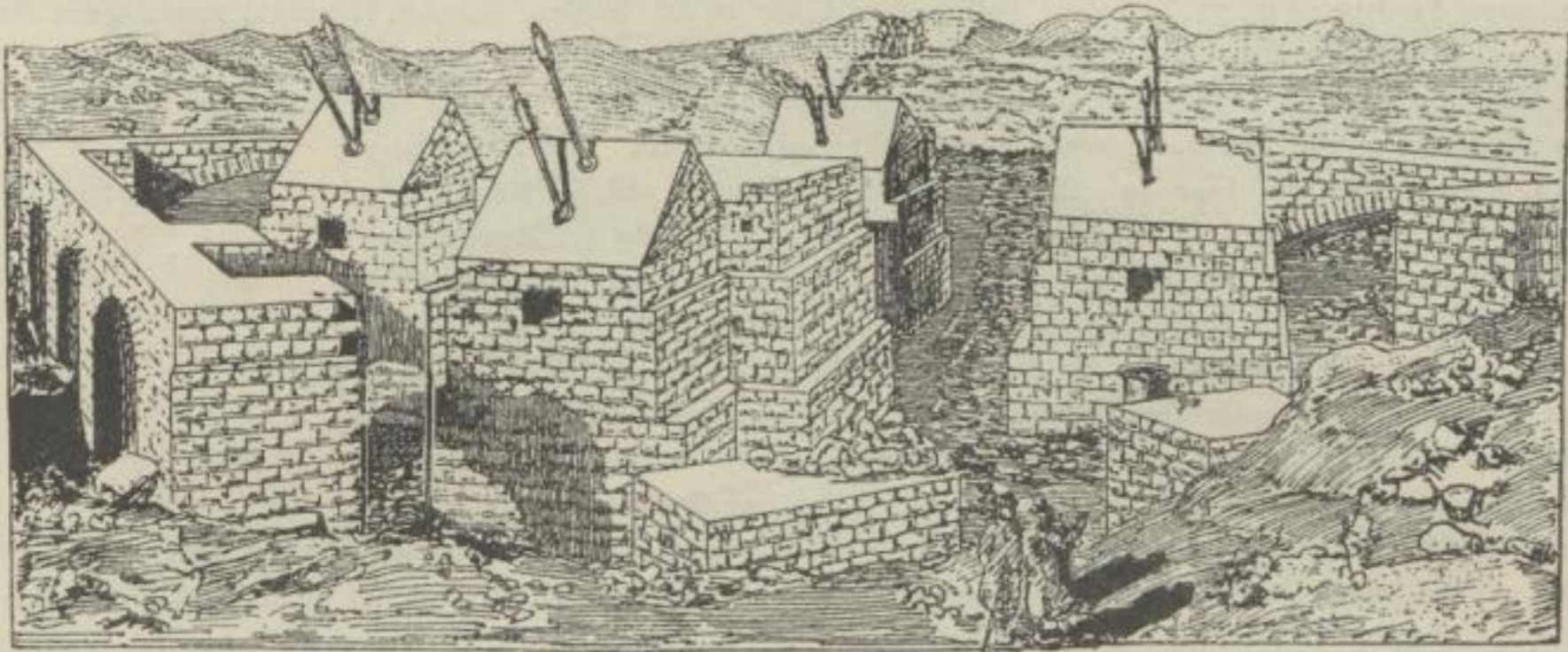
Blick auf die Fundamente eines Eckpfeilers 250 ).
