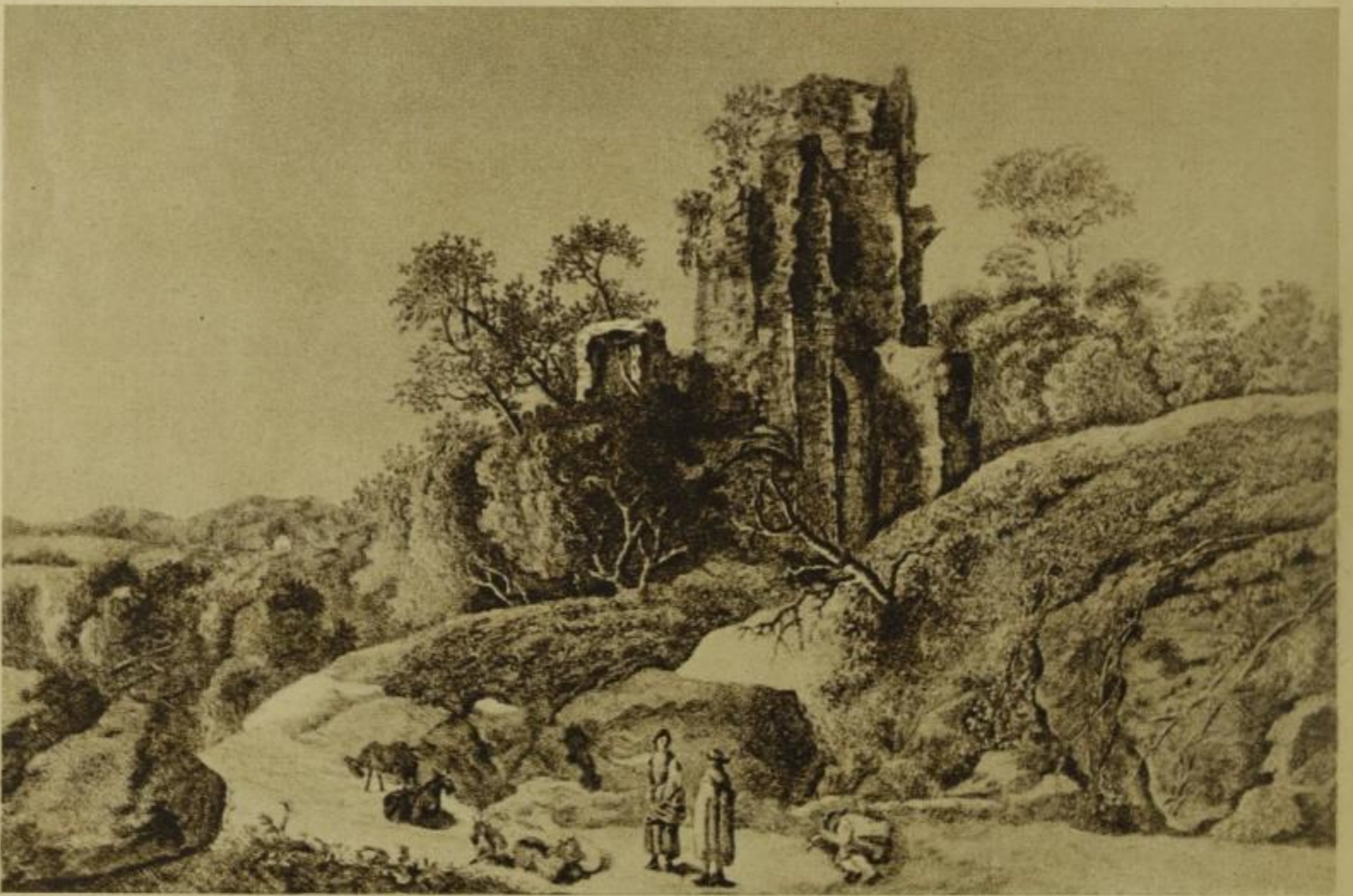
Ehemalige Ruine Rabenau
