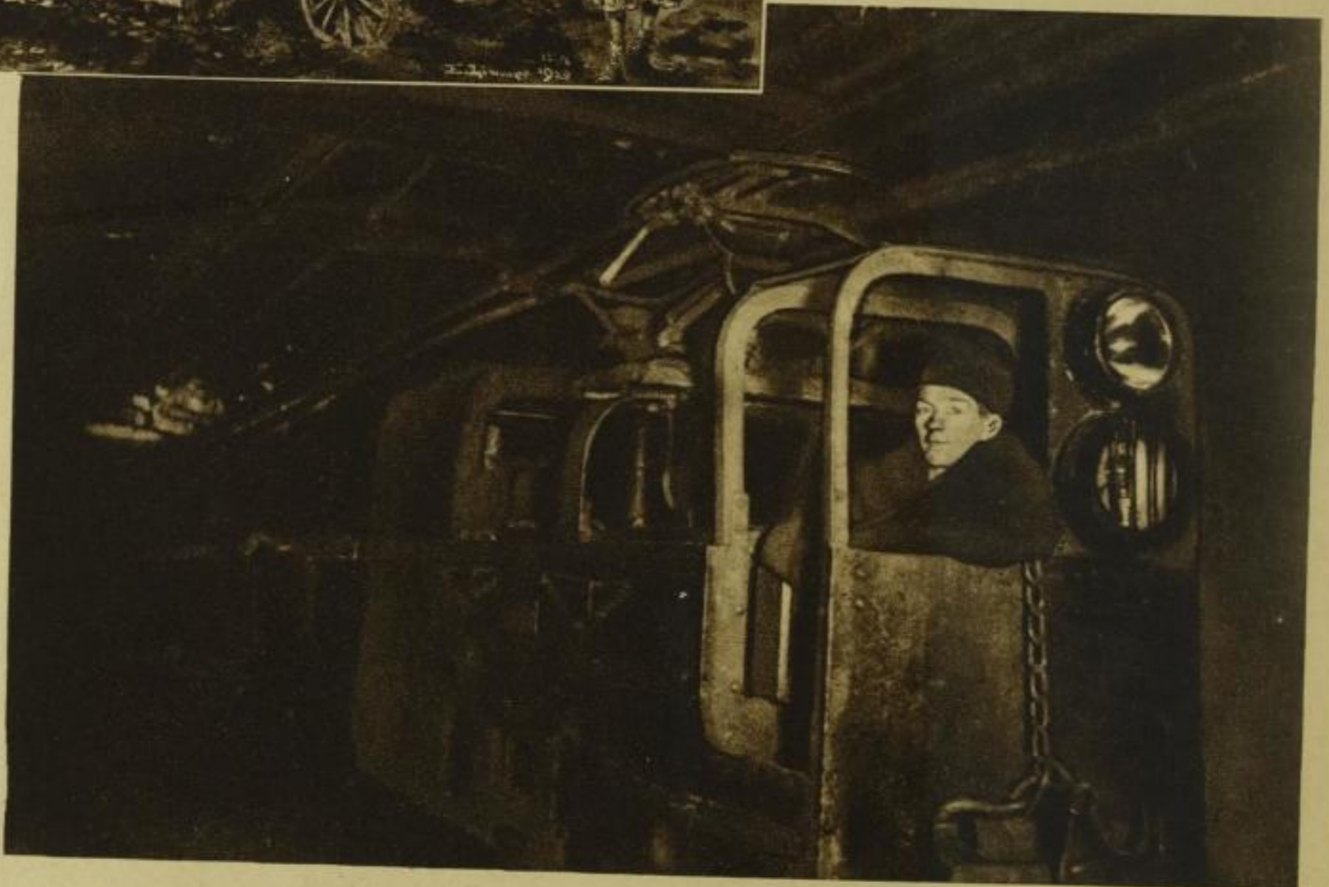
In der Grubenbahn
