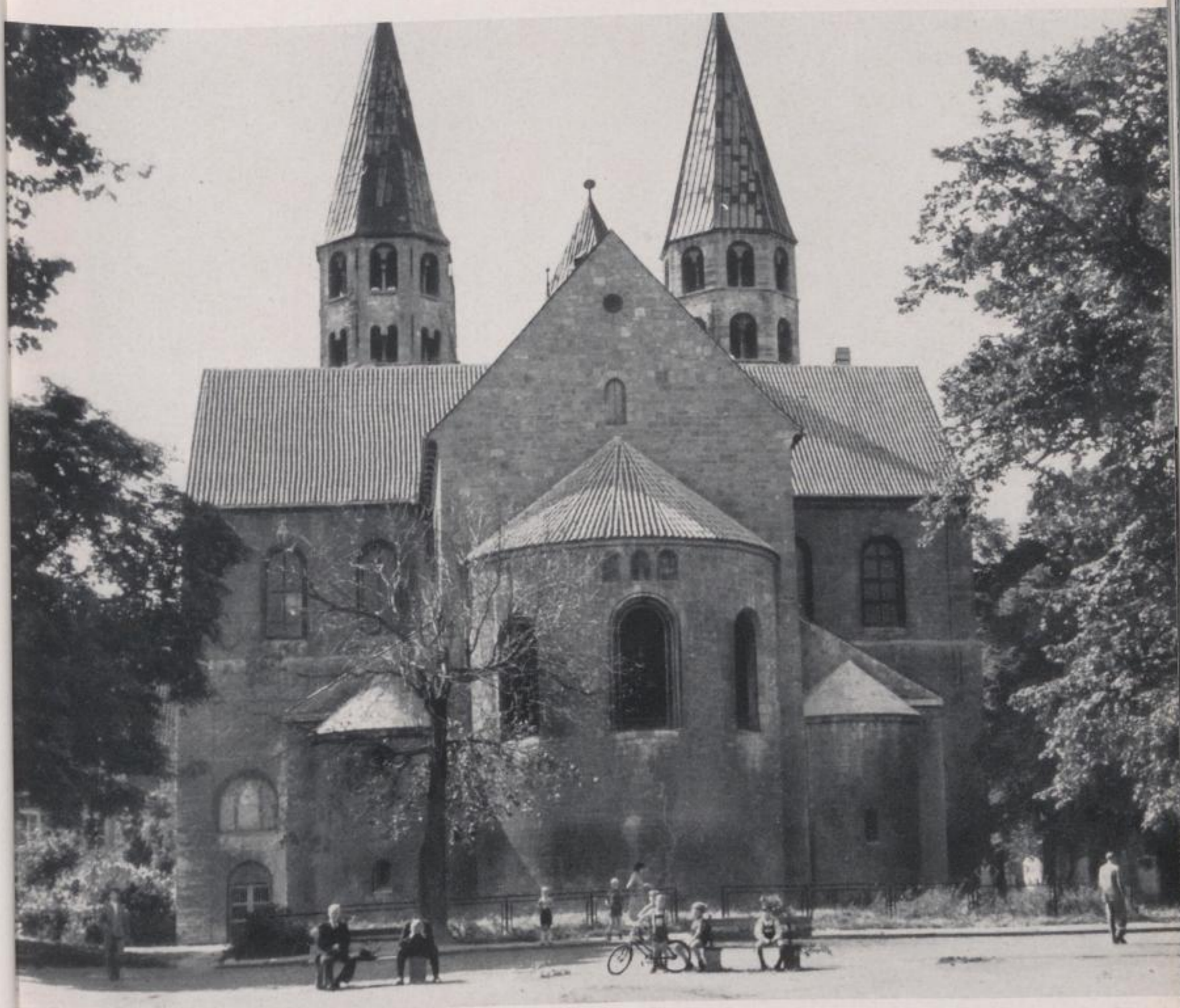
HALBERSTADT, LIEBFRAUENKIRCHE Ostansicht (1956)
