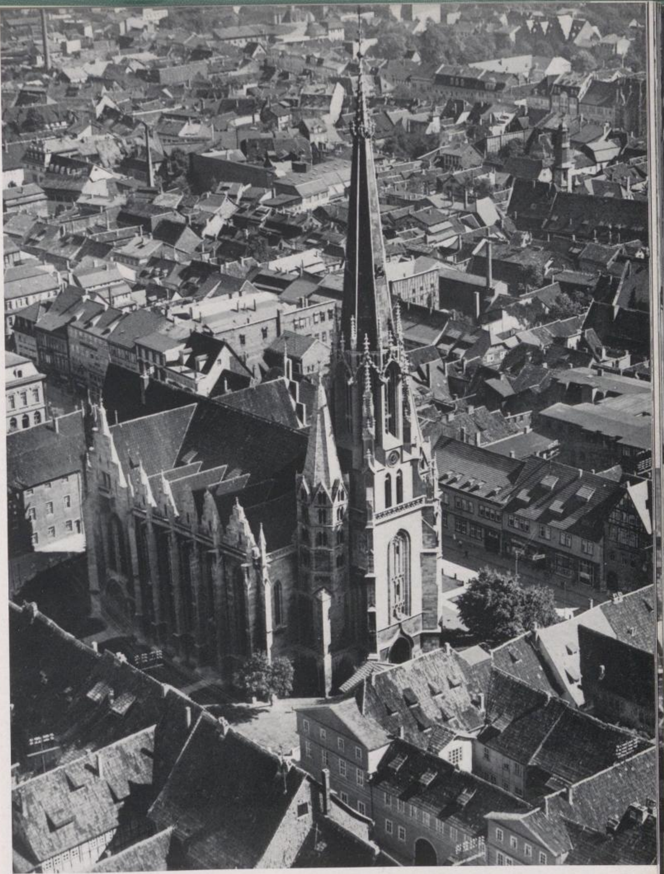
MÜHLHAUSEN, MARIENKIRCHE Luftaufnahme von Nordwesten
