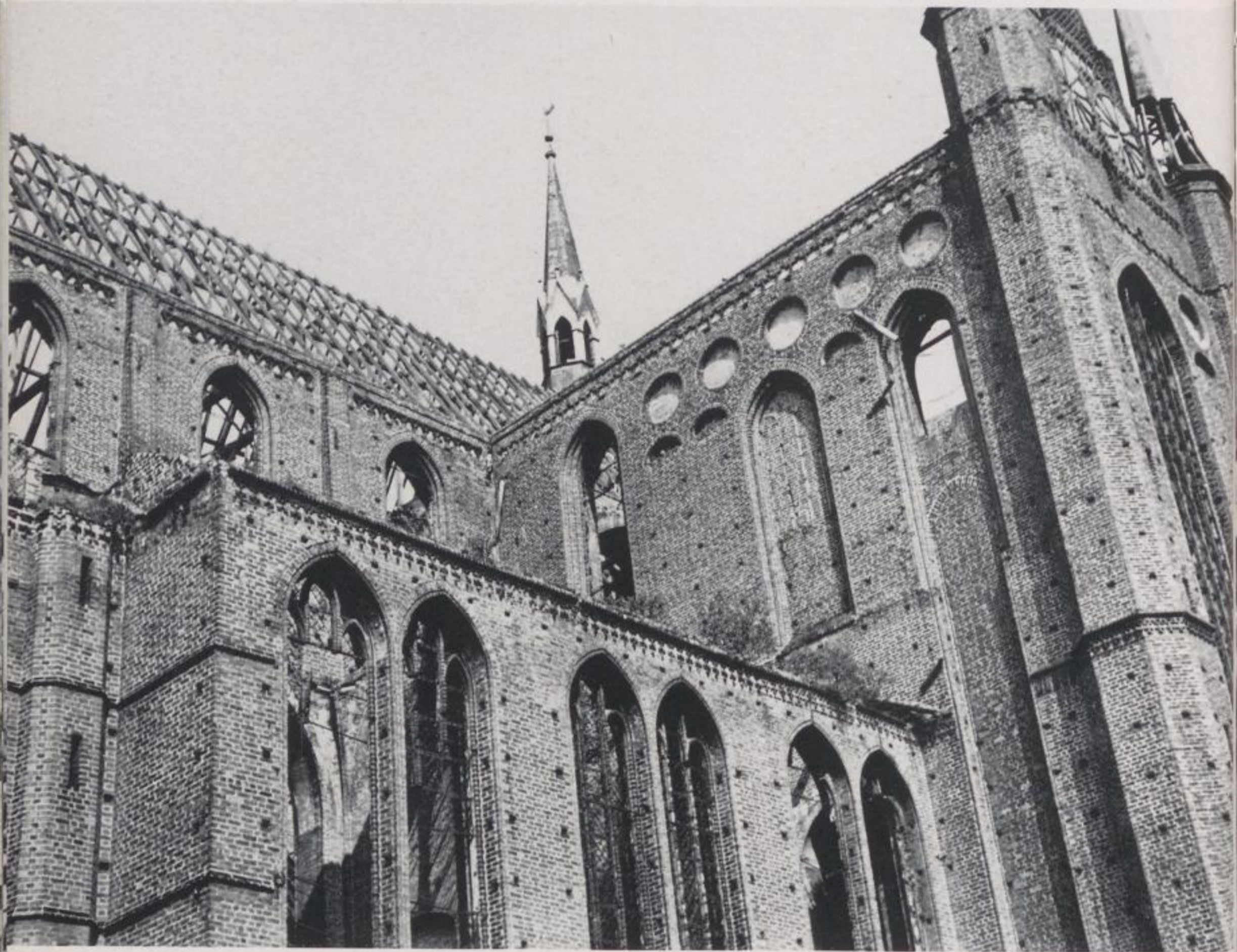
WISMAR, GEORGENKIRCHE Südliches Langhaus und Querschiff (1961)
