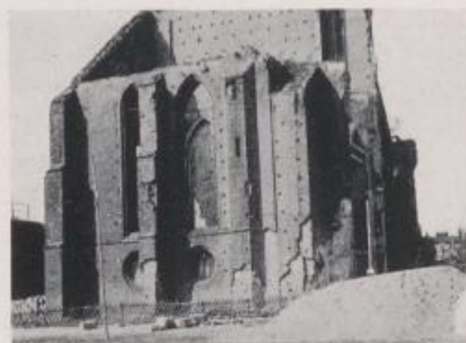
WISMAR Marienkirche, Untergeschoß des Turmes nach der Sprengung von 1960 (Foto 1961)
