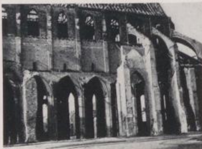
WISMAR Marienkirche, Langhaus und Chor von Süden (1957)
