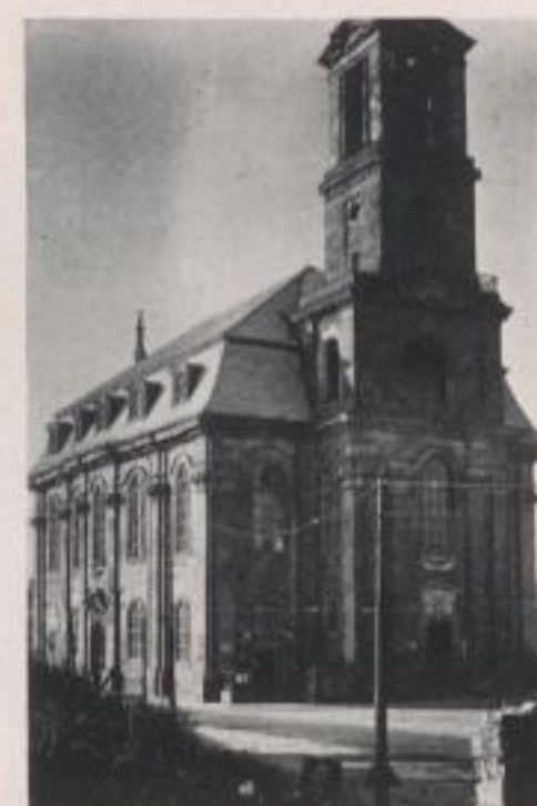
DRESDEN Annenkirche nach Wiederherstellung (1951)
