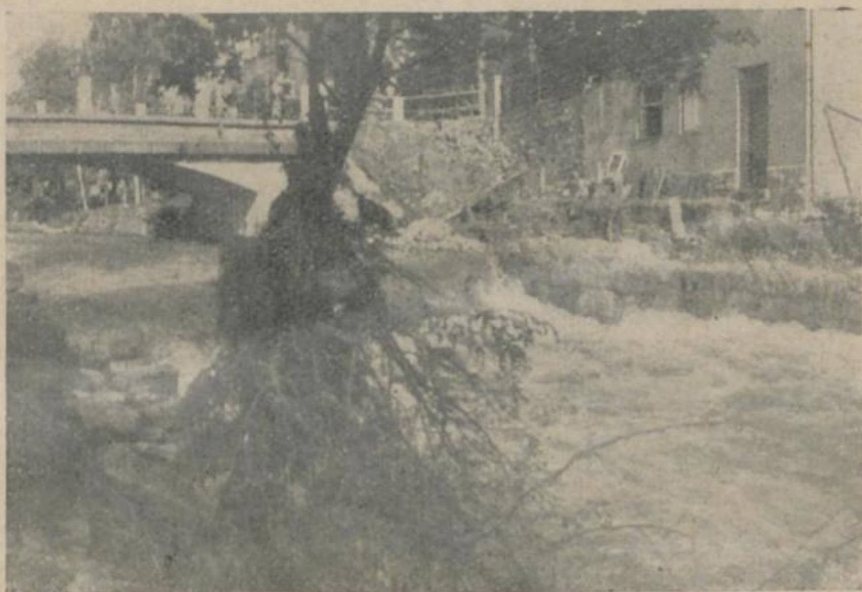
Schwarzenberg: Zerstörungen bei der Reichsbank nach der Flut
