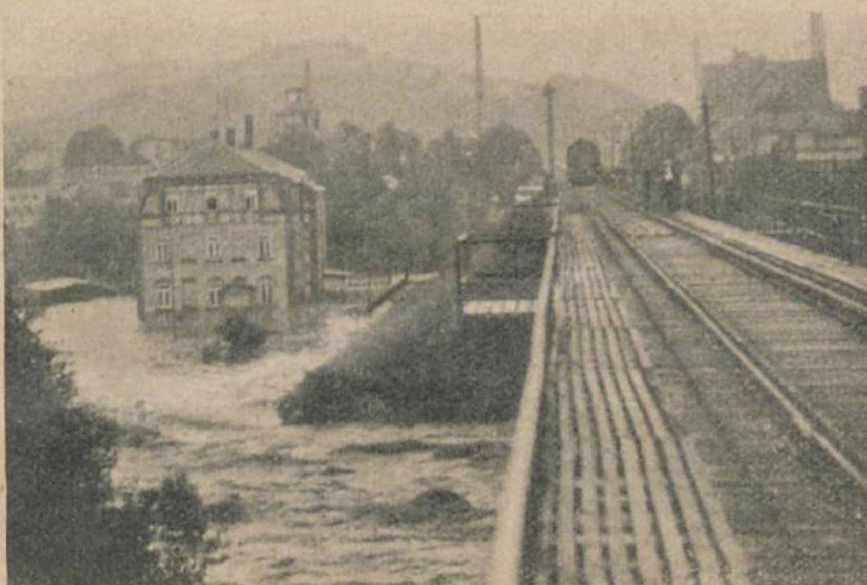
Schwarzenberg: Das „Frommelt-Haus“ im Wasser
