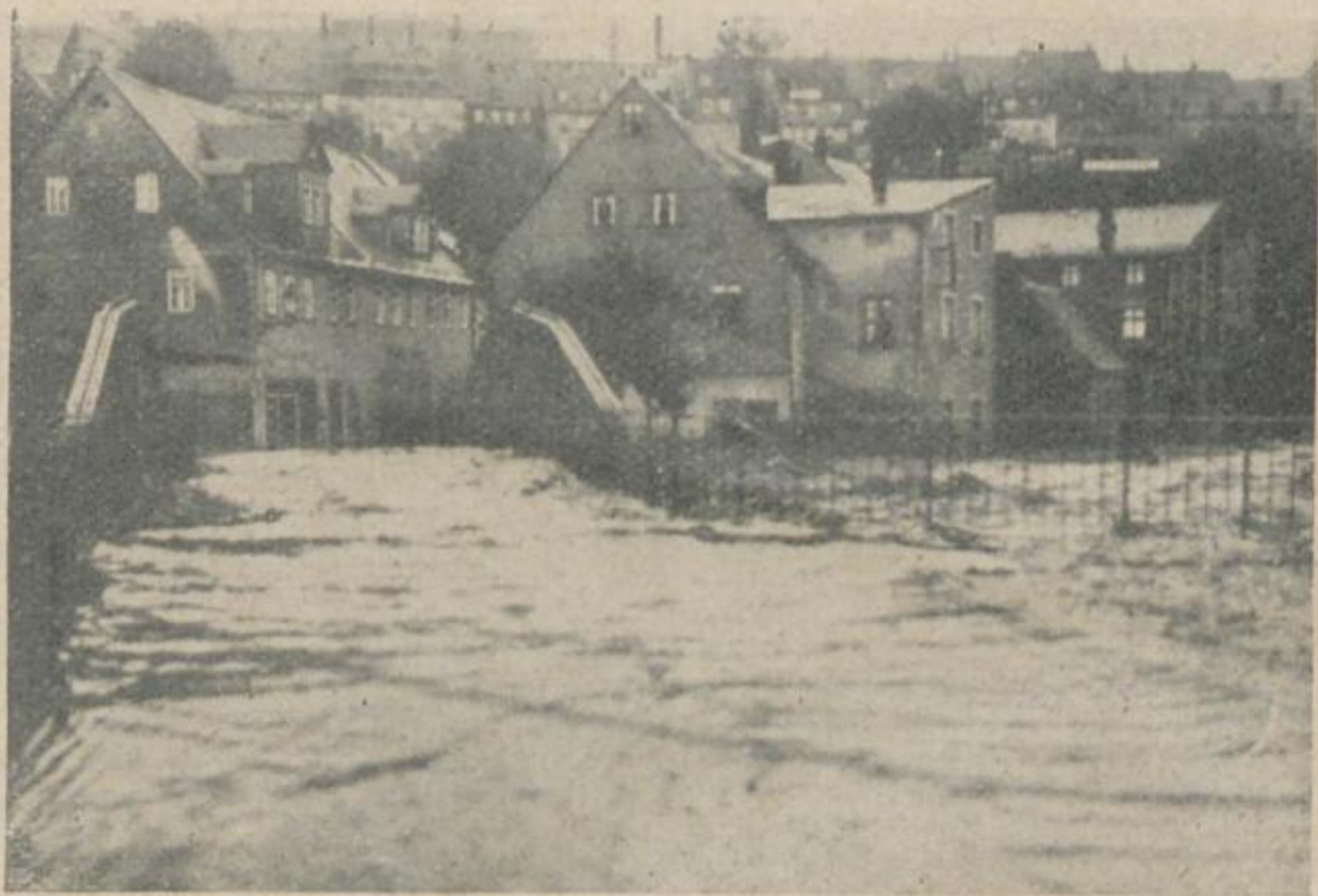
Schwarzenberg: überflutete Brücke in der Vorstadt
