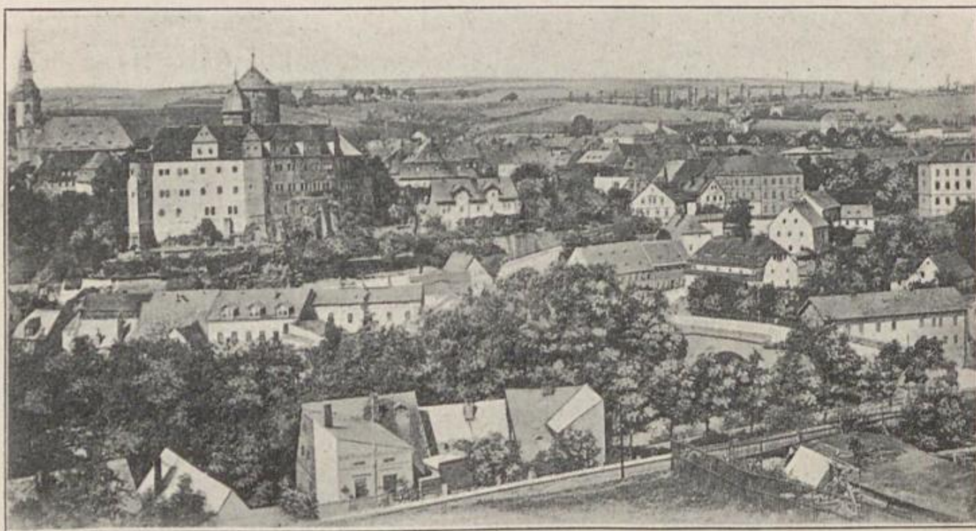
Gesamt-Ansicht 2 von Zschopau. Kunze
