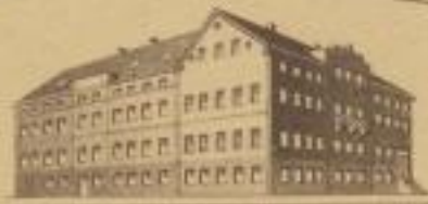
LAGERGEBÄUDE, KLINGENTHAL AM MARKT
