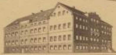
LAGERGEBÄUDE, KLINGENTHAL AM MARKT
