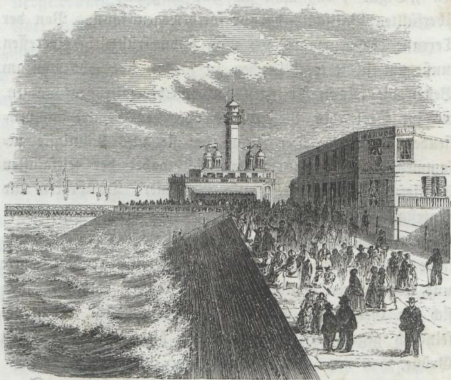
Digue de mer.
