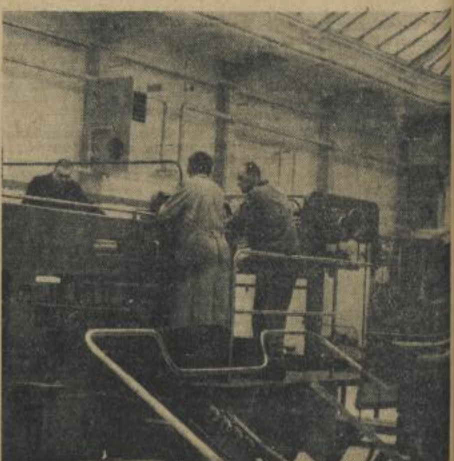
Professor Dipl.-Ing. Adler mit Mitarbeitern seines Instituts für polygrafische und Papierverarbeitungsmaschinen in der neuerbauten Halle an der Reichenhainer Straße beim Aufstellen der Maschinen des Versuchsfeldes.
