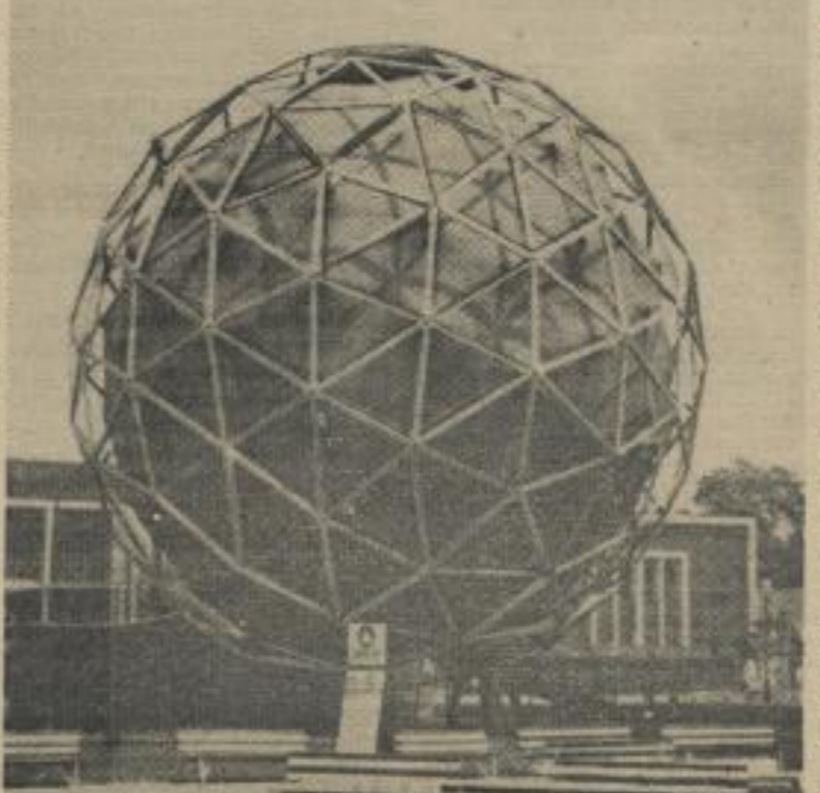
Eine sehr interessante schweißtechnische Aluminiumkonstruktion stellt ein riesiger Kuppelbau dar, den die ungarischen Teilnehmer der IV. Internationalen schweißtechnischen Tagung Z. Buray und I. Kadar, Budapest, in ihren Vorträgen zeigten.
