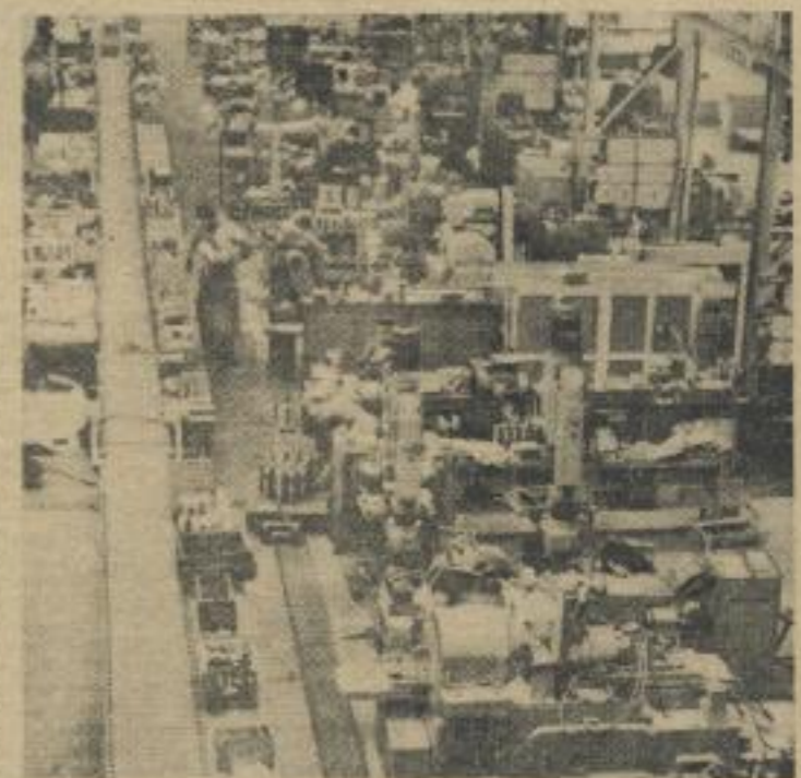
Automatisierung in der DDR. - Moderne Wechsellagermaschinen mit Rollenbändern für den Transport der Werkstücke im VEB WEMA Pilsener.
