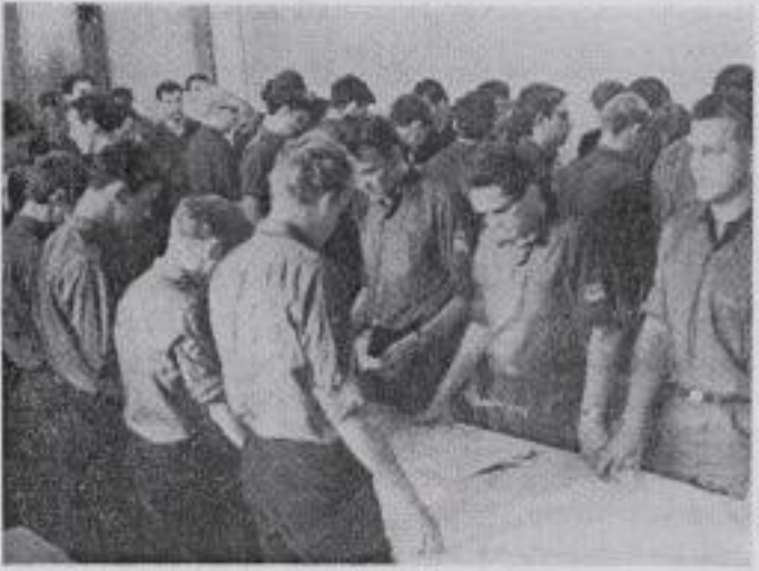
Unsere Fotos: Die „Dahlemer“ Studenten beim Bau einer Zufahrtsrampe zum Kühlhausneubau (oben). – Während der feierlichen Verabschiedung der FDJ-Studentenbrigade gebieten ihre Mitglieder, alle Kraft für die Stärkung unserer sozialistischen Republik einzusetzen.
