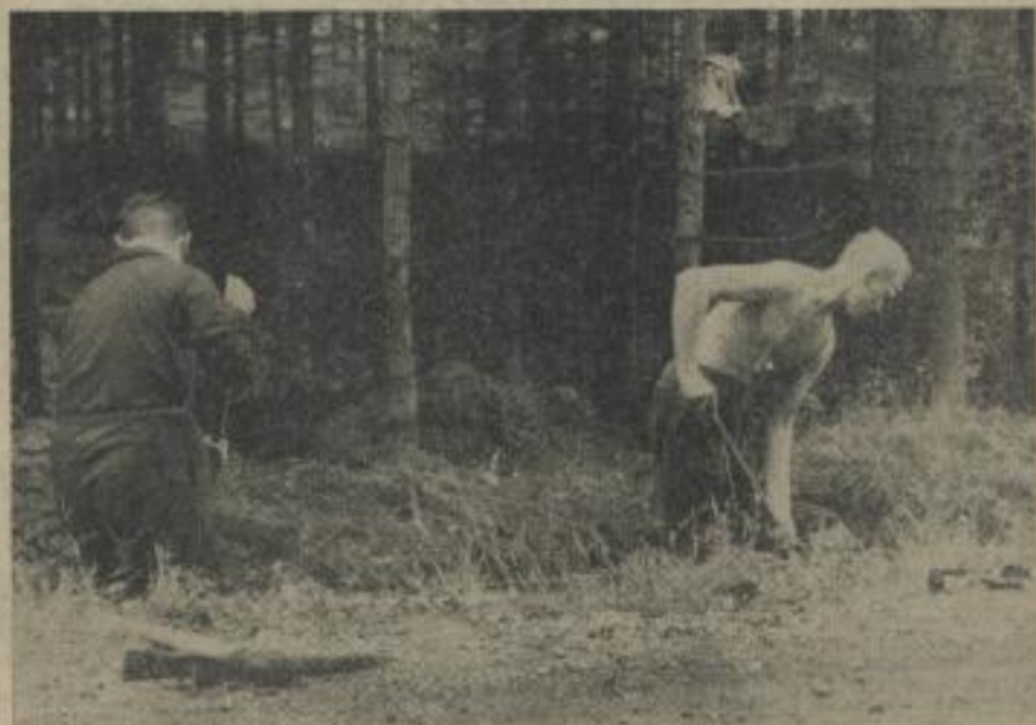
Am 28. Juli hat der 25-jährige Einsatz unserer FDJ-Studentenbrigaden begonnen. Über 1000 Jugendfreunde sind für vier Wochen am Bezirksjugendobjekt „Wasserleitungsplan Oberwiesenthal“, am Großtauklager Hartmannsdorf und auf Baustellen im Stadtgebiet von Karl-Marx-Stadt im Einsatz. Der 25. Juli stand in Oberwiesenthal ganz im Zeichen der aktiven Solidarität mit dem vietnamesischen Volk. Über 40 Hochschullehrer, an ihrer Spitze Genosse Hans-Jürgen Uebertuhr, stellvertretender Sekretär der Hochschulparteileitung, Genosse Prof. Dr. rer. nat. habil. Frieder Kubner, Dekan der Fakultät für Mathematik und Naturwissenschaften, und der Sekr. für der FDJ-Hochschulleitung, Genosse Gerhard Schreiber, beteiligten sich an einer Vietnam-Sonderfahrt. Am Nachmittag fand in der Jugendherberge „Bruno Kühn“ in Jöhstadt ein Solidaritätsmeeting mit vietnamesischen Freunden statt. Auf diesem Meeting wurden über 4000 Mark für das heldenhaltig kämpfende vietnamesische Volk übergeben. Damit haben unsere Freunde einen guten Beitrag zum endgültigen Sieg der fortschrittlichen Kräfte in Südostasien geleistet.
