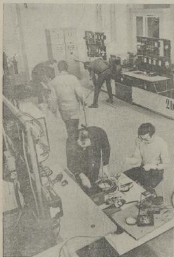
Reinigungs- und Installationsarbeiten werden hier im neuen Sektionsgebäude geleistet.
