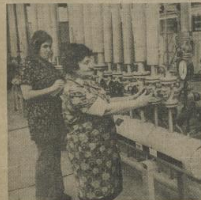
Die Kolleginnen Rita Pechan und Hilde Pypez in der neuen Umformstation des Sektionsgebäudes.
