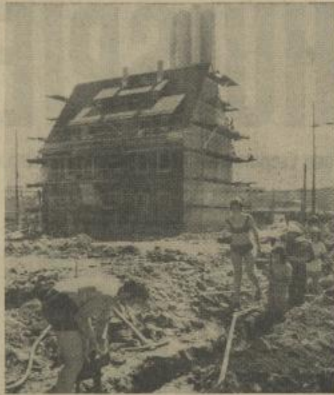
Unsere Studentenbrigade beim Einsatz im Vorgelände des Fritz-Hecker-Gebäudehauses.
