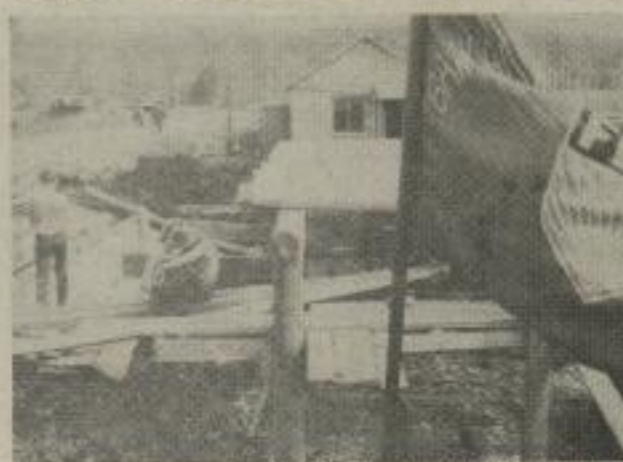
Die Fahne unseres Jugendverbandes weht über der Baustelle unserer Baugrube.
