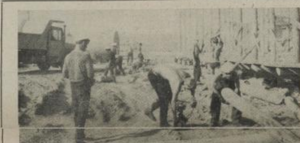
Der Aufbau der Baustellentechnik ist die erste Arbeit.
