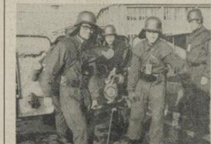
Die technischen Einrichtungen müssen gut gepflegt und ständig auf ihre Funktionstüchtigkeit überprüft werden.
