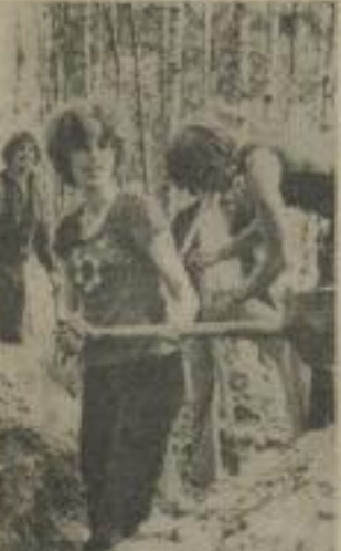
Studenten der Matrikel 76 der Sektion AT helfen im Ferienlager „Clara Zetkin“ in Limbach beim Bau neuer Bungalows.
