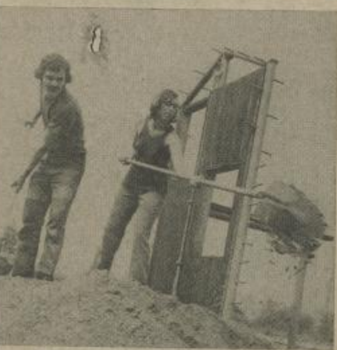
Kerstin Söfel, Dietmar Schüttendiebel (25/11) und viele andere halfen im Bereich unserer Hochschule, notwendige Instandhaltungsarbeiten durchzuführen.
