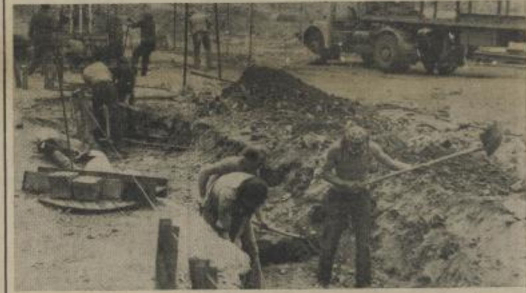
Studentennummer 74. Zwei FDJ-Studentenbrigaden unserer Hochschule, deren Studenten der Sektion Fertigungsprozess und -mittel und Informationstechnik angehören, halten beim Bau der Straßenbahntrasse Gabeln.
