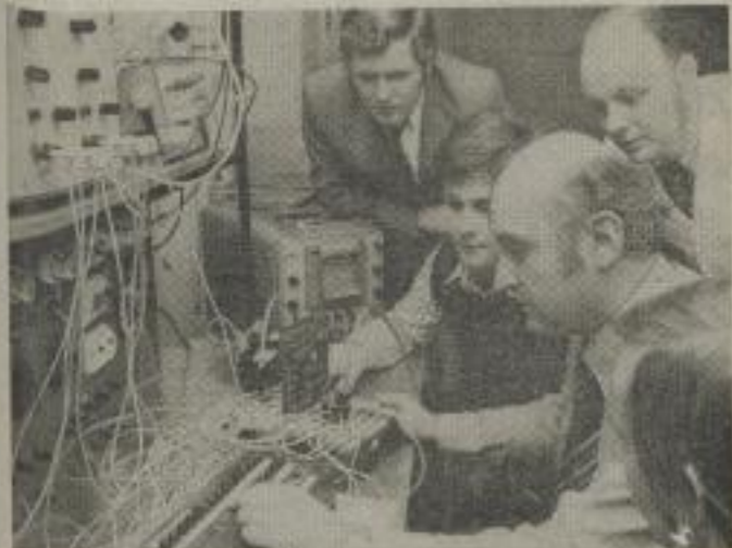
Ein Kollektiv des Wissenschaftsbereiches Prozeßautomatisierung und Geräteelektronik unter Leitung von Prof. Dr.-Ing. Wolfgang Fritsch (3. v. l.) baut und nahm den ersten Mikrorechner der TH in Betrieb. Er wird als Prozeßrechner zur Steuerung technologischer Vorgänge im Be- und Vorleistungsmaschinenbau eingesetzt. Der Wissenschaftsbereich unterhält enge Kontakte zum VEB Starkstromanlagenbau und dem Institut für Elektroanlagen Berlin der VVB Automatisierungs- und Elektroenergieanlagen.
