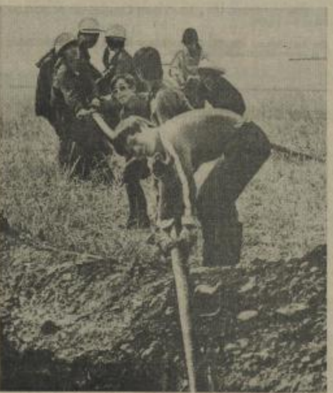
Hervorragende Leistungen vollbrachten unsere vietnamesischen Studenten, die im Rahmen des Studentensommers 1977 einen Arbeitsbesuch im TVK Karl-Marx-Stadt durchführten. In enger Zusammenarbeit mit jungen Bauarbeitern unserer Stadt halfen sie beim Bau der Zentralwerkstatt und anderer wichtiger Objekte. Für ihre guten Arbeitsleistungen wurden einige der vietnamesischen Studenten mit Geldpreisen ausgezeichnet.
