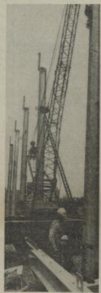
Das Aufstellen der Stahlstützen für die neue Sporthalle unserer Hochschule.
