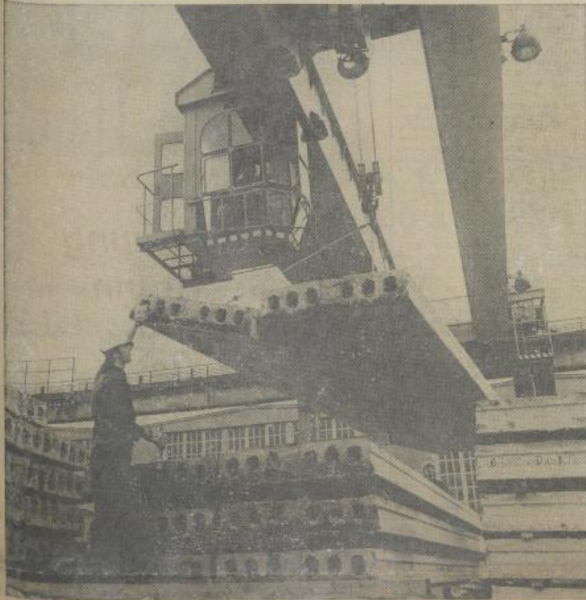
Ob Bauarbeiter oder Student, das läßt sich so ohne weiteres nicht sagen, zumal alle Freunde der 77/25 (FPM), die vor dem Studium eine Facharbeiterausbildung abgeschlossen haben, im VEB Betonwerke Berlin-Grünau in ihrem erlernten Beruf eingesetzt sind. Andreas Richter trifft wir bei Verdarbeiten, andere Mitglieder seiner FDJ-Gruppe sind in der Abteilung Hauptmechanik tätig.
