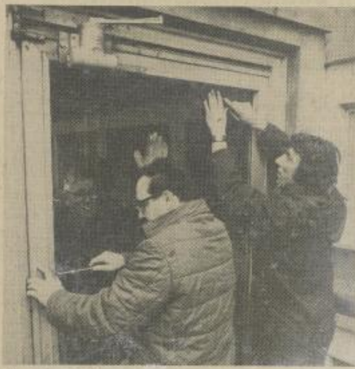
Wir trafen die Kollegen Mathias Kulig, Erwin Vogt und Alfred Lohs beim Verglasen der Haupttüren des Wohnheims Veltersstraße 64/66.
