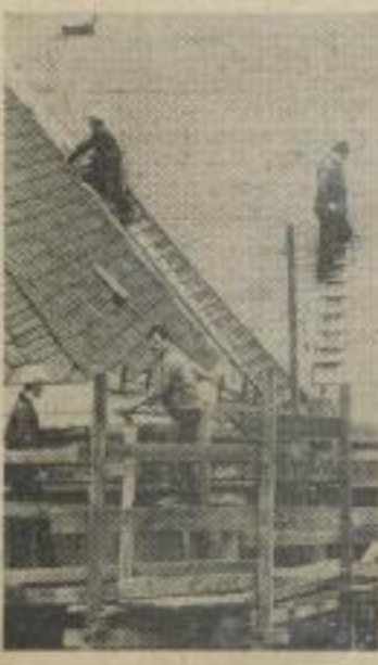
Die Kollegen der Hauptabteilung Grundfondswirtschaft setzen alle Kräfte ein, um die Dachdecker- und Klempnerarbeiten im Bereich Straße der Nationen vor Winterbeginn abzuschließen.
