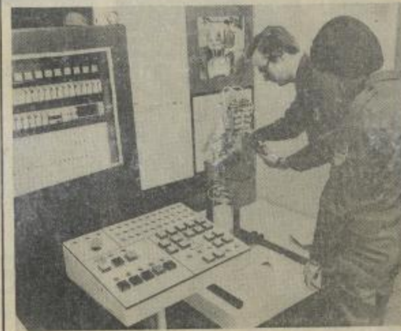
Das Exponat „Greifer für Industrieroboter“ fand auf der Hochschulleistungsschau das Interesse vieler Besucher. Das ausgestellte Funktionsmodell eines Greifers mit drei Freiheitsgraden und pneumatischen Antrieben und pneumatischer Steuerung dient der Untersuchung von Funktionsprinzipien und Baugruppen für Greifer von Manipulatoren und Industrierobotern.
