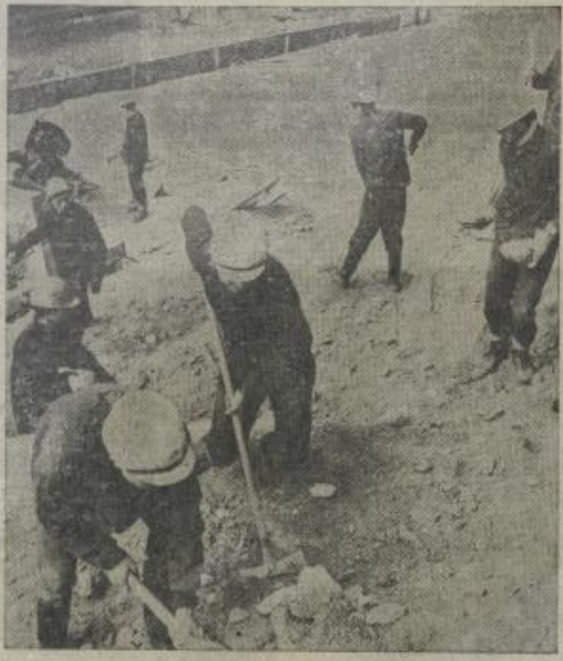
Am Einsatzort Eisenstock halfen Studenten unserer Hochschule tatkräftig beim Bau der Talsperre mit.
