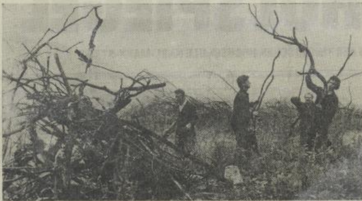
Damit später die Aggregate in der Staumauer nicht gefährdet werden, ist es notwendig, den Stauraum gründlich zu räumen. Unsere Studenten halfen mit, Bäume und Reisig aus dem künftigen See zu entfernen bzw. zu verbrennen.
