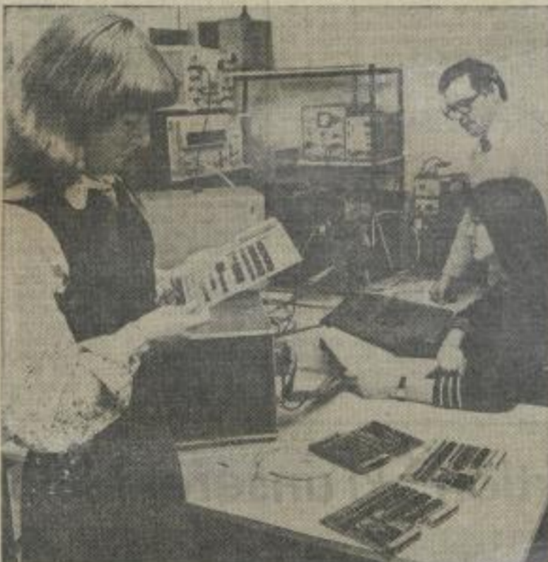
Studenten und junge Wissenschaftler der Sektion Informationstechnik entwickelten im Rahmen des Jugendobjektes „Datenklassifikation“ ein Bildverarbeitungssystem auf Mikrorechnerbasis. Dieses kann unter anderem als Erkennungssystem in Industrierobotern eingesetzt werden.
