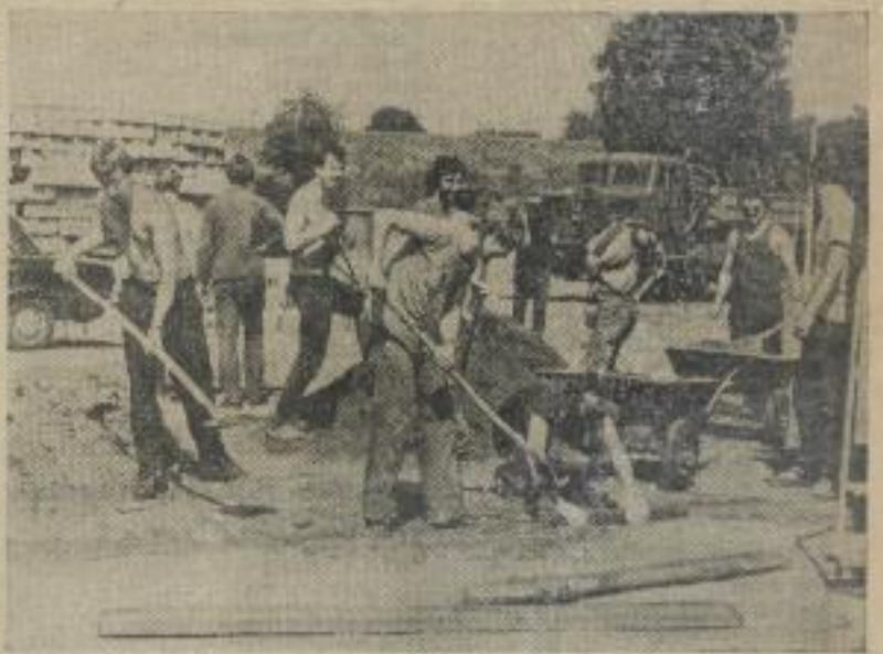
Bei der Errichtung eines Lagerplatzes für das ITVK Berlin halfen FDJ-Studenten unserer Hochschule.
