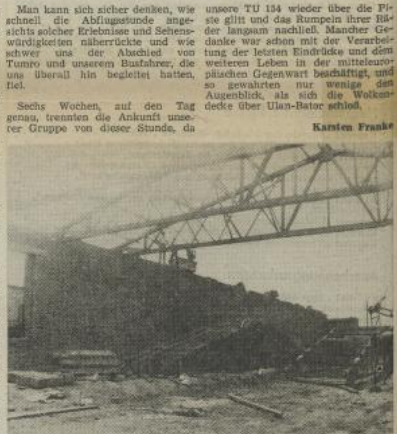
Die Arbeit am Bau der Pflanzkartoffelhalle geht voran.
