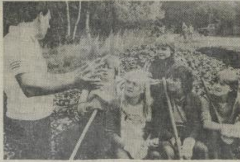
Mit dem Bau eines ca. 300 m langen Fußweges zwischen Reichenhain und Erfenschlag wird ein lang gehegter Wunsch nicht nur der Hochschulangehörigen erfüllt. 22 TH-Studenten und 30 polnische Studenten haben diese Aufgabe der Bauleiters Rainer Haury (Bild li.) haben sie schon gute Ergebnisse erreicht. Und trotz mancher Verständigungsschwierigkeiten kommt auch der Spaß nicht zu kurz.
