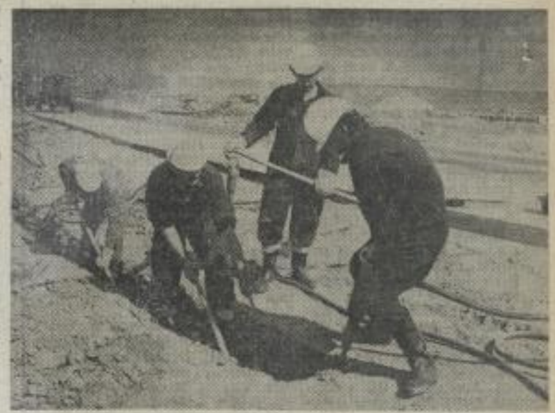
Auch diese FDJler sind im Jahre 1974 dabei gewesen, als der Bau des Pumpspeicherwerkes Markersbach jede Hand brauchte. Mit ihren Leistungen schrieben sie sich in die Chronik der Studentenbrigaden ein.
