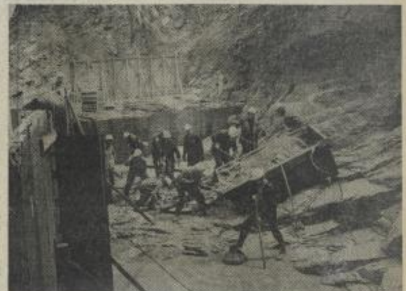
Ebenfalls 1978 arbeiteten die FDJler unserer Hochschule im Studentensommer beim Bau der Talperre Eibenstock mit. Gemeinsam mit Freunden aus sozialistischen Ländern erfüllten sie die verantwortungsvolle Aufgabe, den Fels für die Betonarbeiten vorzubereiten.
